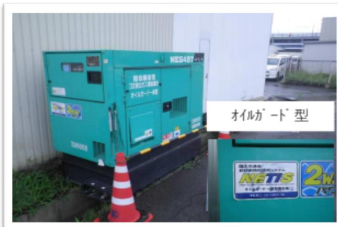
環境配慮型発電機の使用により油 流出防止の実施
