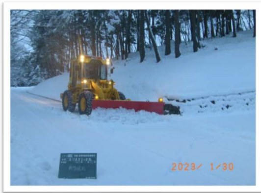
除雪作業の様子
